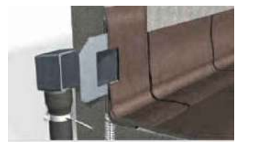
Sumideros laterales en cubierta.
